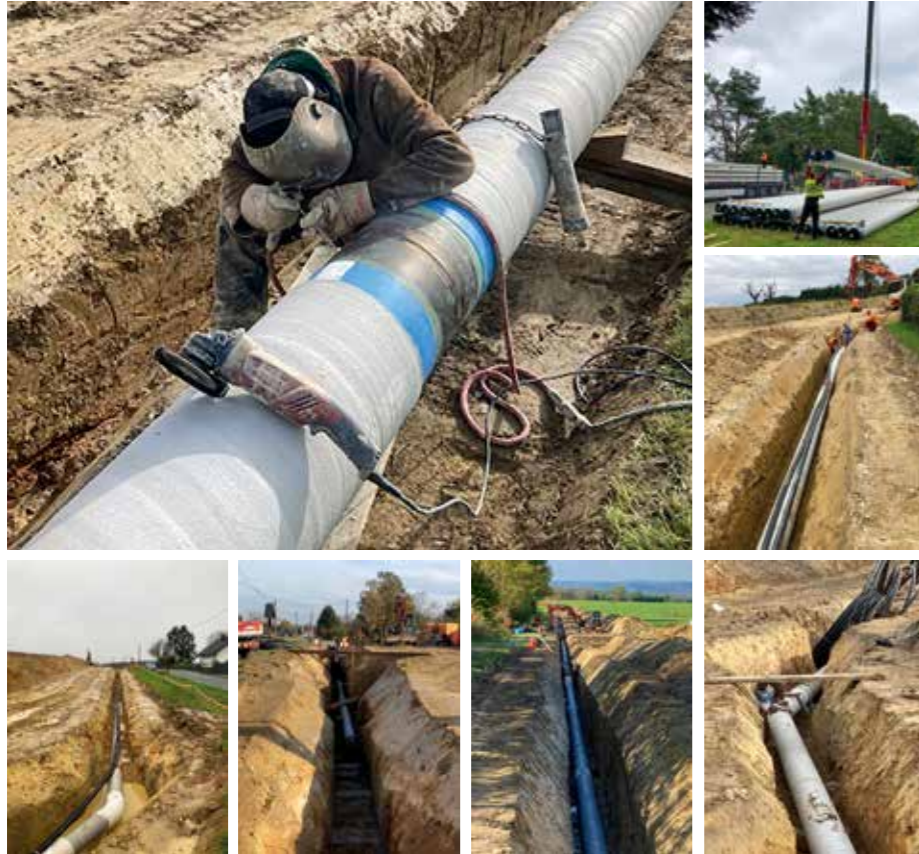
Fotos Verlegung der neuen Wassertransportleitung.
