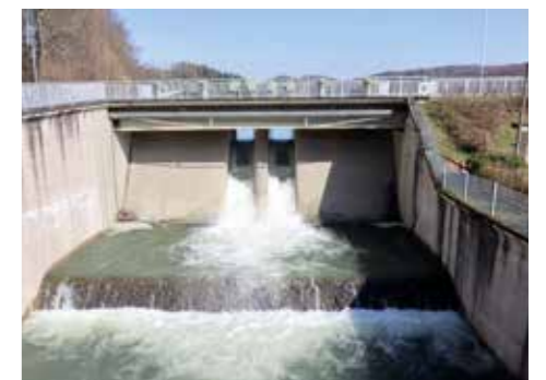
Foto unten Bei der Hochwasserentlastung wird das Wasser aus der Talsperre in ein Becken hinter der Staumauer abgelassen und in den Wahnbach abgeleitet.
