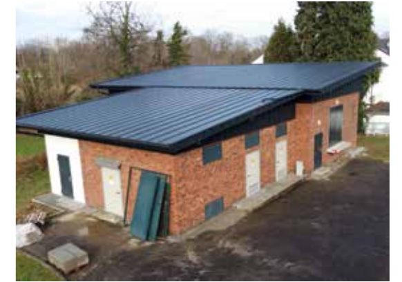
Foto Dacherneuerung Pumpstation Lengsdorf
